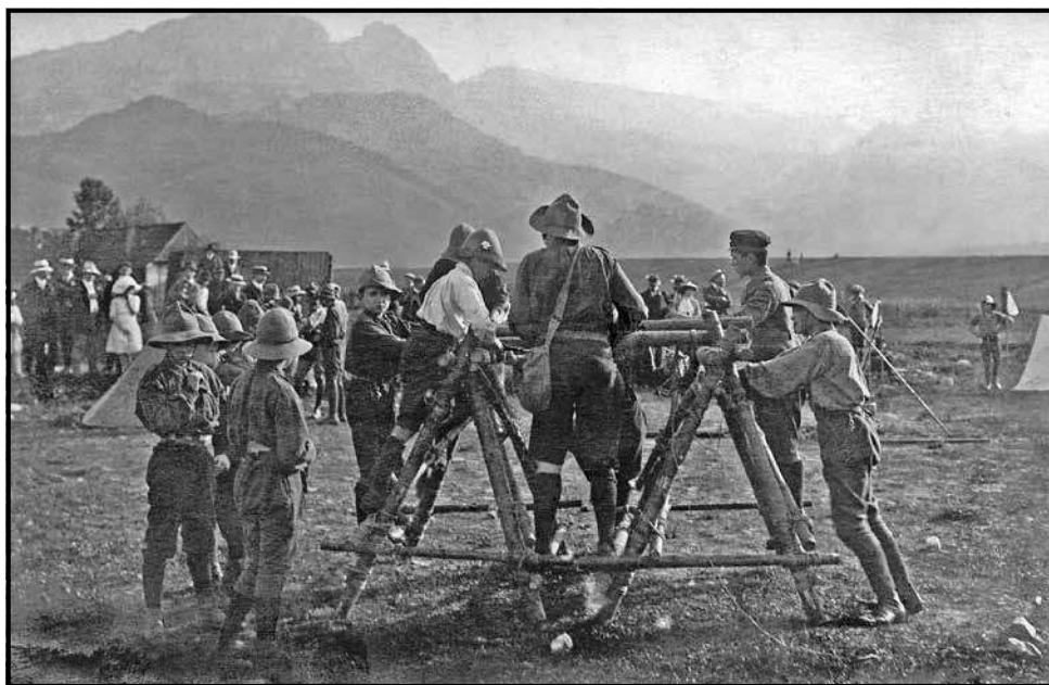
Popis skautów – budowa mostu na boisku Sokoła w Zakopanem pod kierunkiem Andrzeja Małkowskiego (stoi tyłem w kapeluszu), 24 sierpnia 1913 r. – zbiory Muzeum Harcerskiego w Zakopanem (fot. pierwszy raz reprodukowana)
